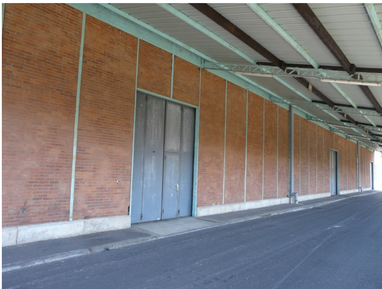
Auvent du bâtiment n° 15
