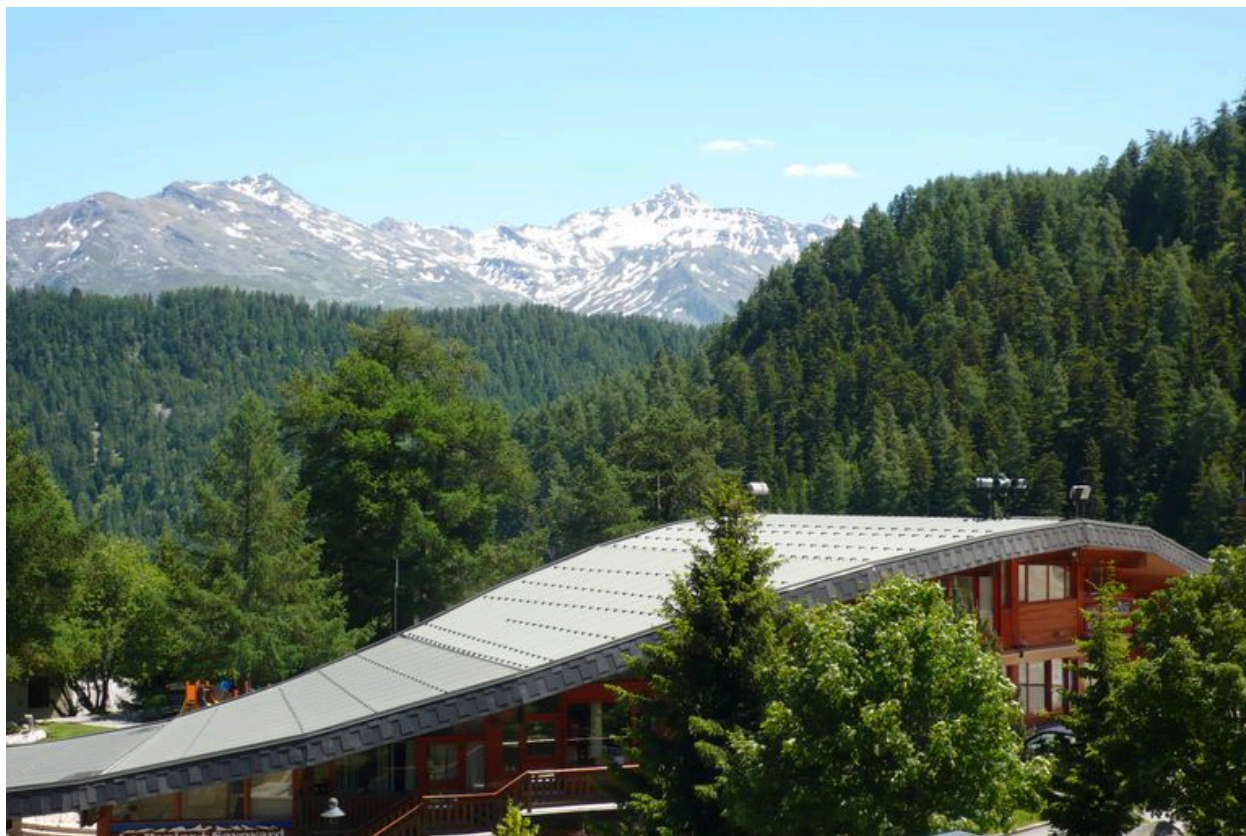
La toiture depuis le nord-ouest
