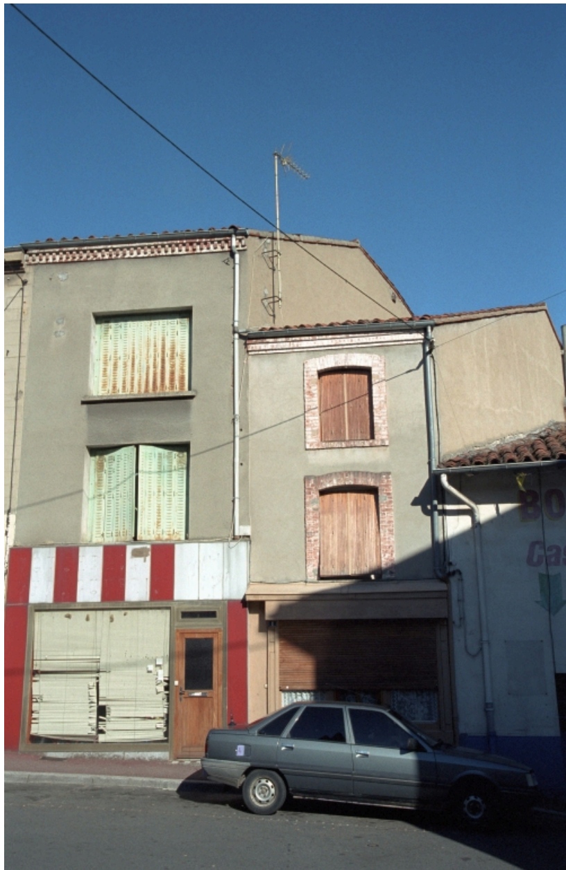
Boën, îlot 18, Saint-Jean (rue) 1, 3. Vue générale de la façade sur rue.
