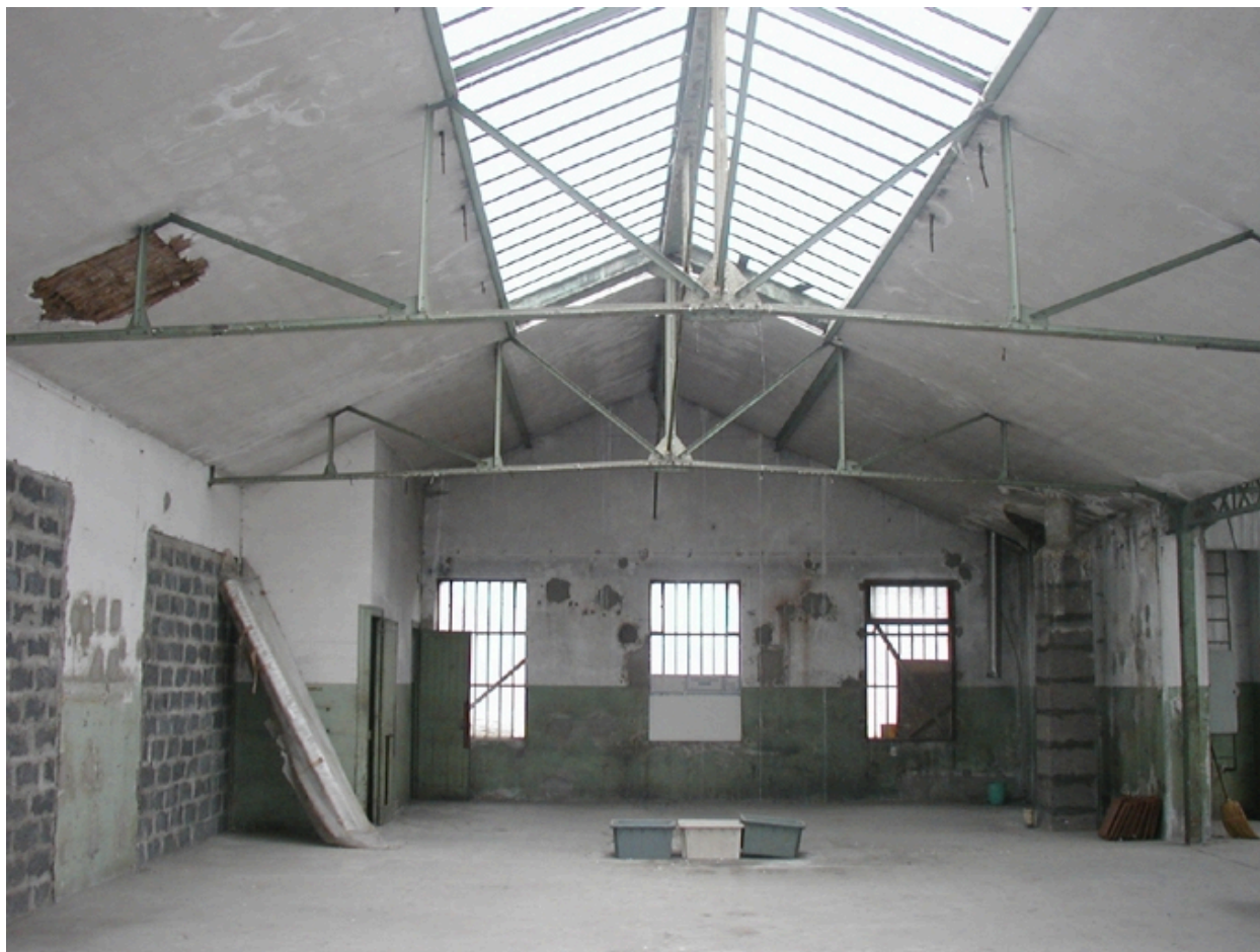
Charpente second niveau
