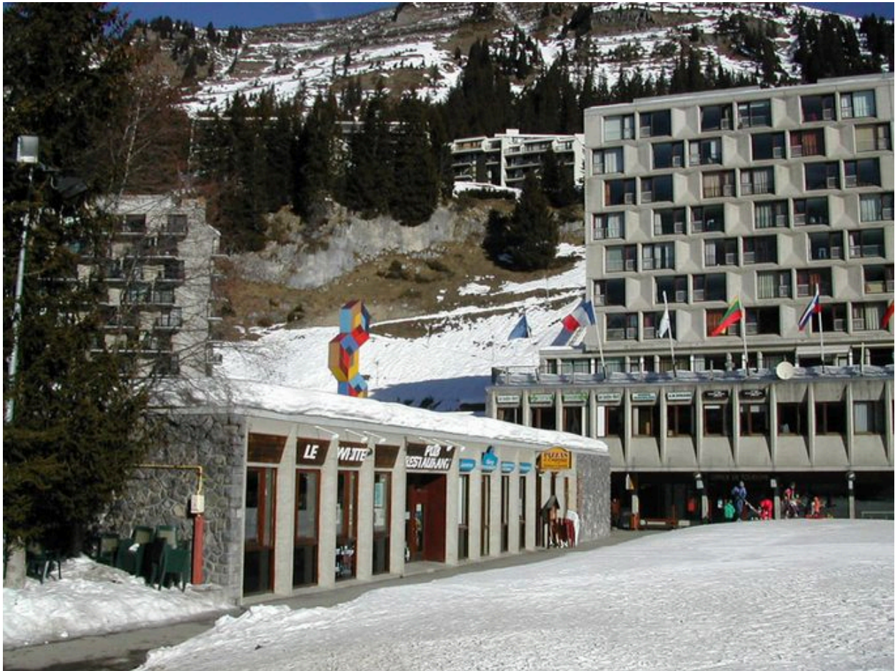
Vue du bâtiment N depuis le sud-est
