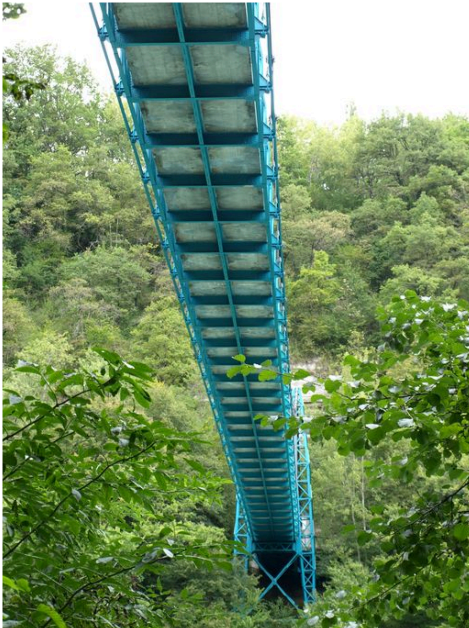
Vue du dessous, tablier de la travée centrale (depuis la rive gauche)
