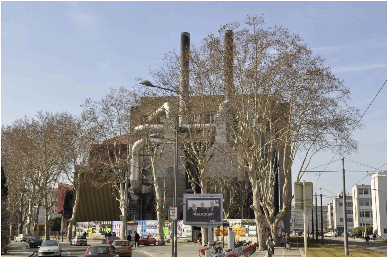
Vue d'ensemble de la chaufferie
