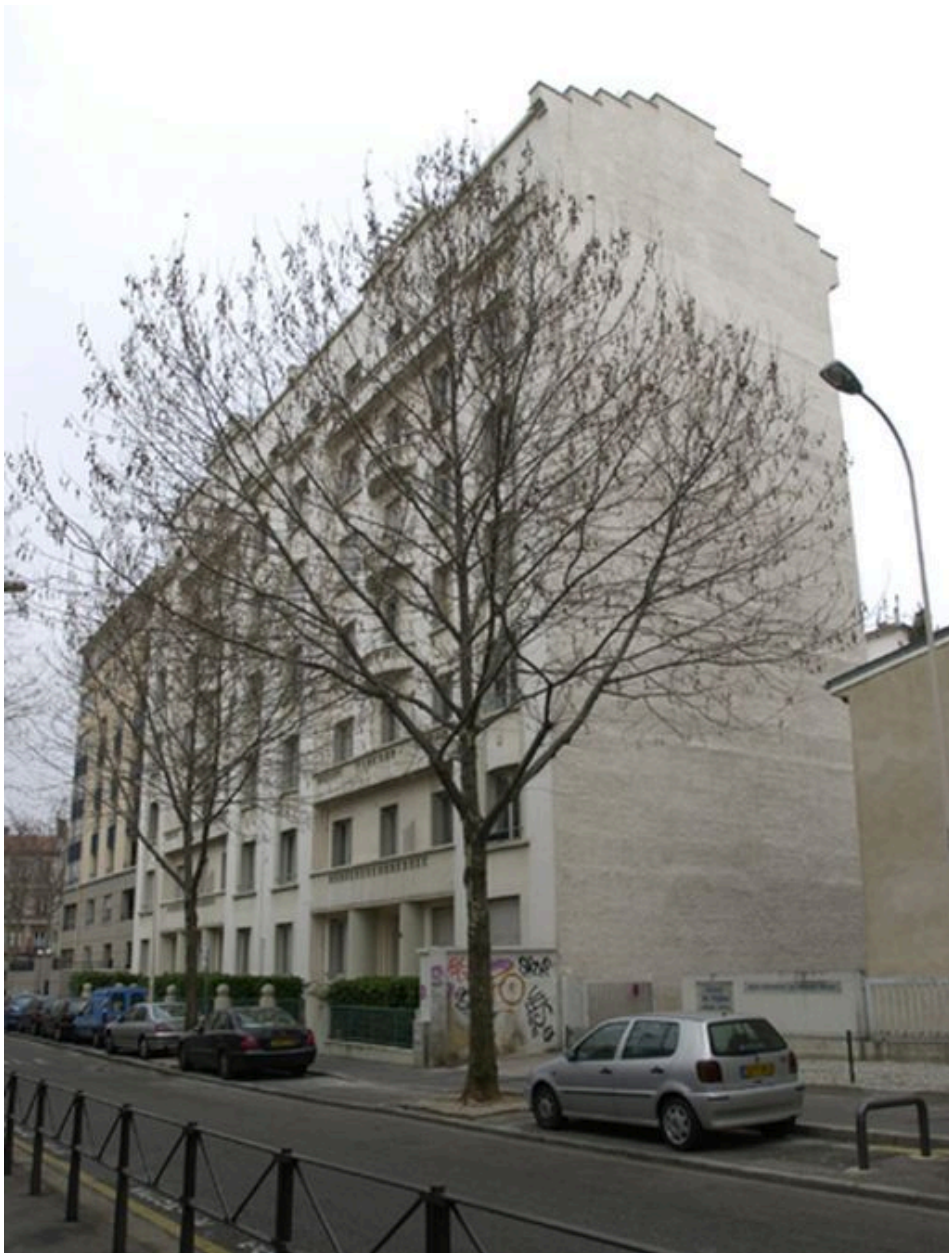
Vue générale des 2 immeubles depuis le nord
