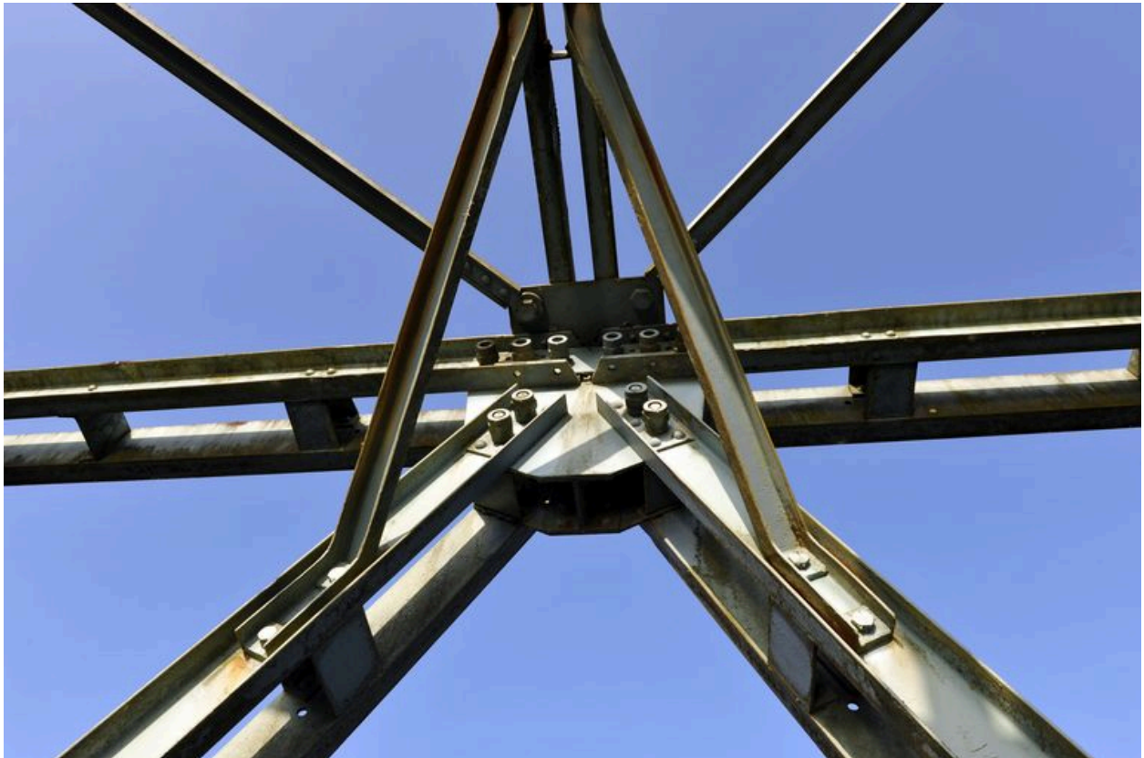
Travée centrale, de dessus, vue de détail : assemblage de la structure métallique, de face
