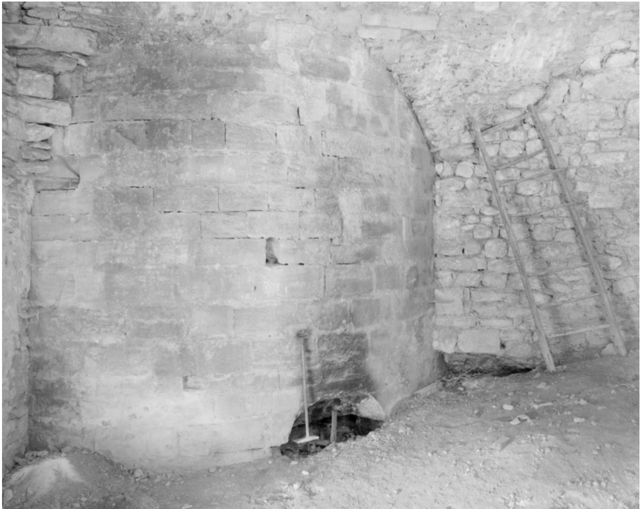
Poterne ouest. La tour. Vue prise depuis la troisième travée de voûte du soutainement de la terrasse.
