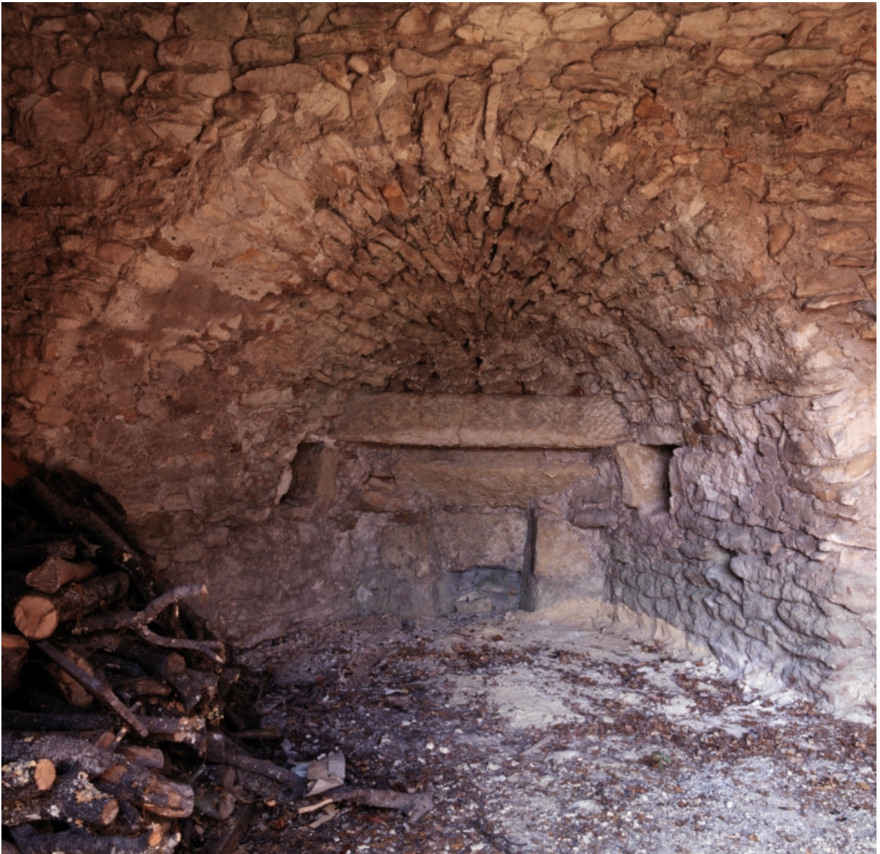
Foyer de gauche du four à chaux.
