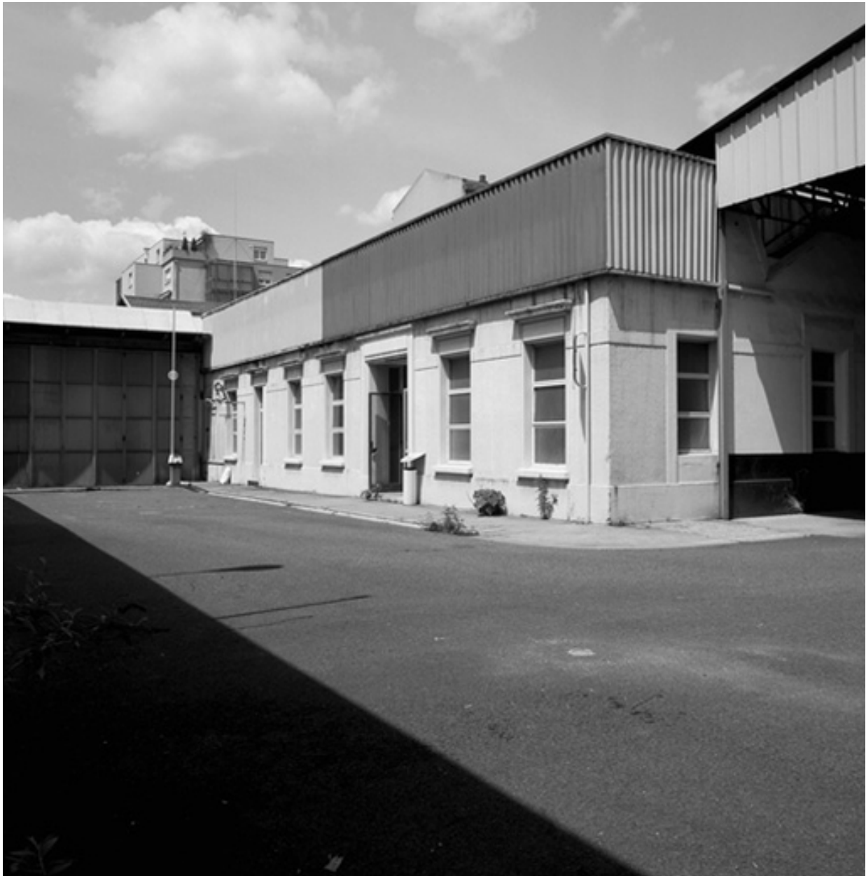
Entrée des bureaux, vue sud
