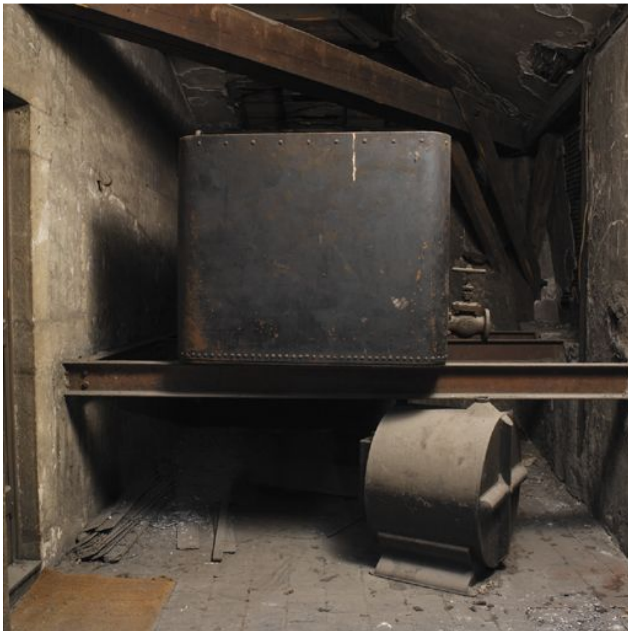
Vestiges de l'ancien chauffage : citerne dans le grenier du corps de bâtiment sud
