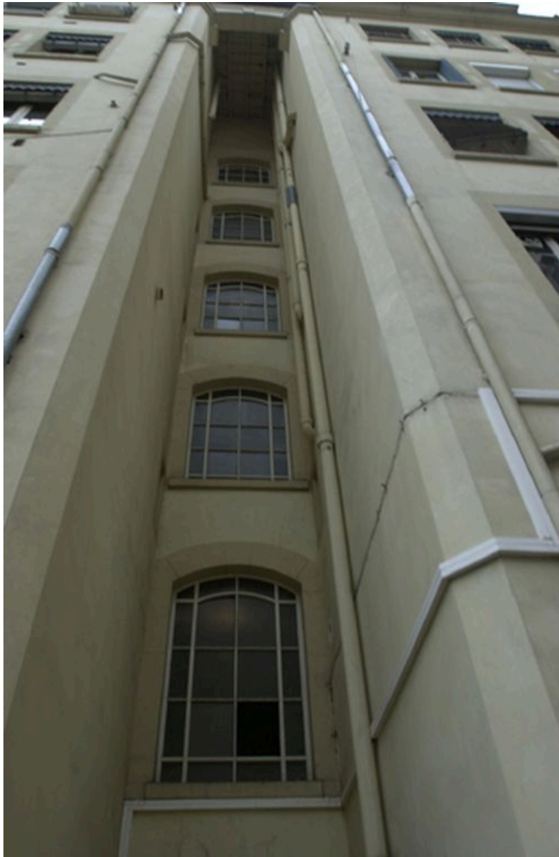
Elévation postérieure, étage de la cage d'escalier
