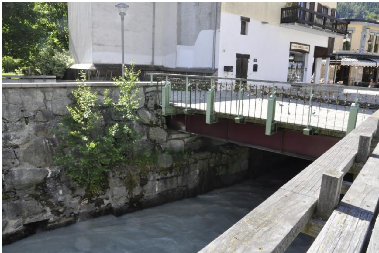
Vue des vestiges de la culée en rive gauche du pont de l'Hôtel d'Angleterre
