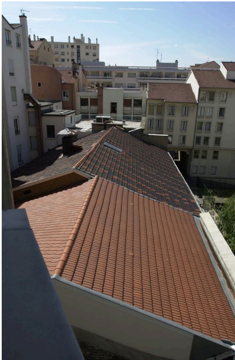
Vue d'ensemble des toits des bâtiments de l'hôtel de Noailles, en coeur d'îlot
