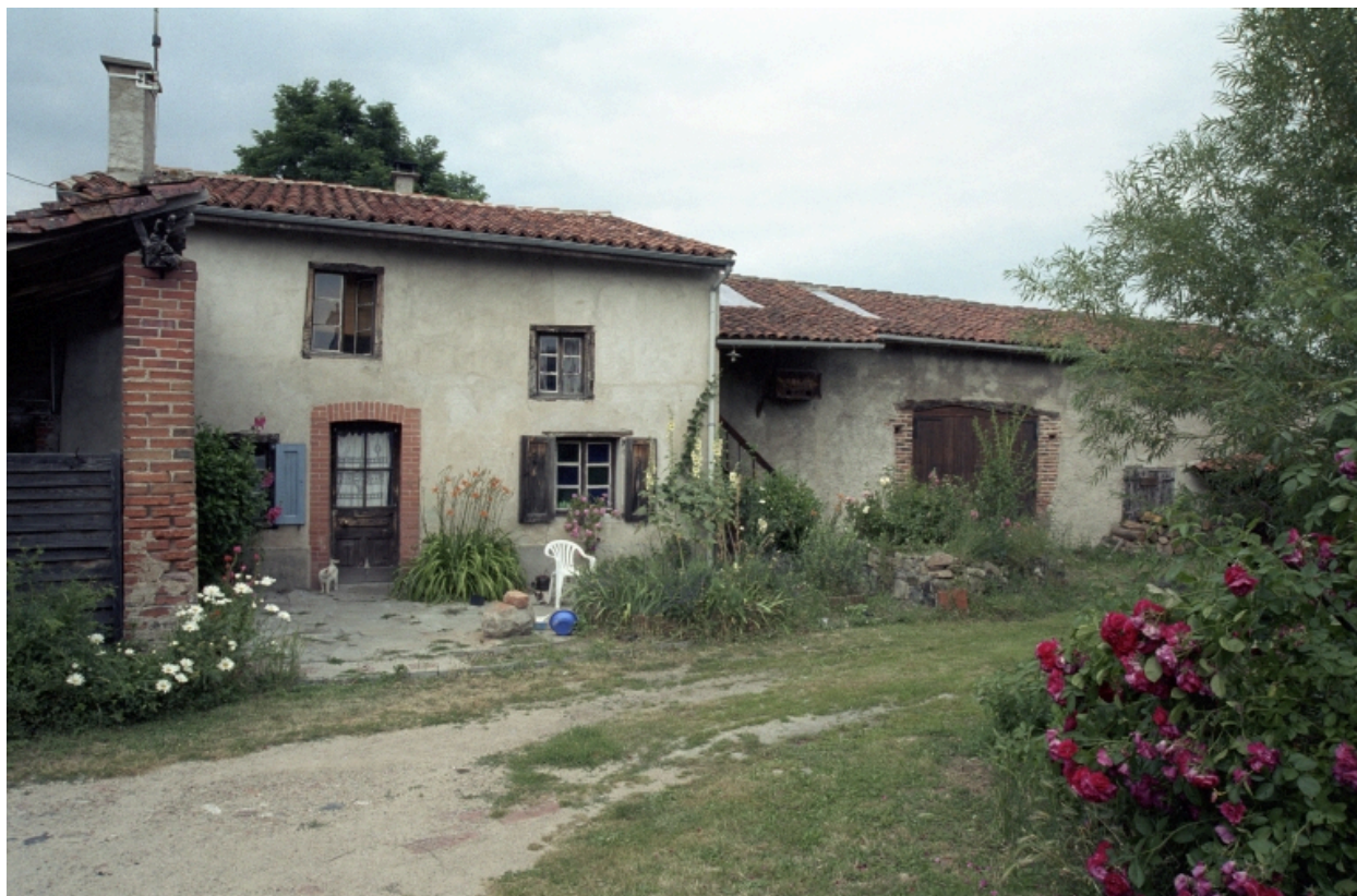
Montverdun, Bourgchanin (1986 A1 298), type A1. Vue d'ensemble du logis et de la grange-étable depuis la cour.
