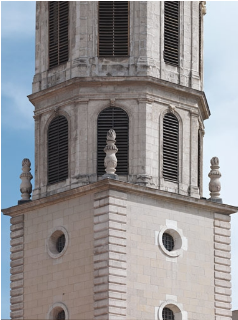
Clocher : vue de détail prise de la place Bellecour, depuis l'ouest, jonction entre la tour et la lanterne
