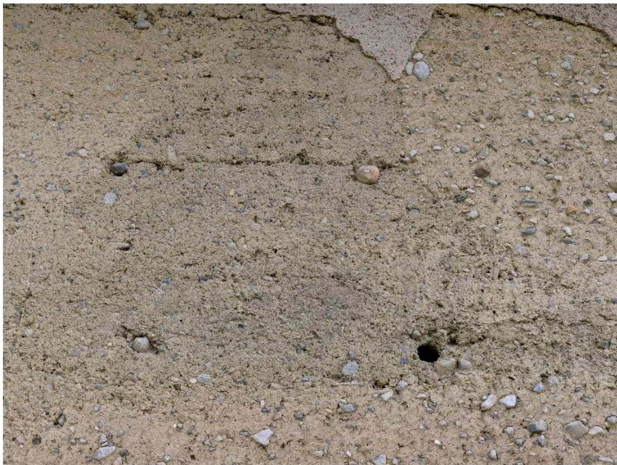
Détail de matériau : pisé (mur arrière), trous de boulins obturés par des galets.
