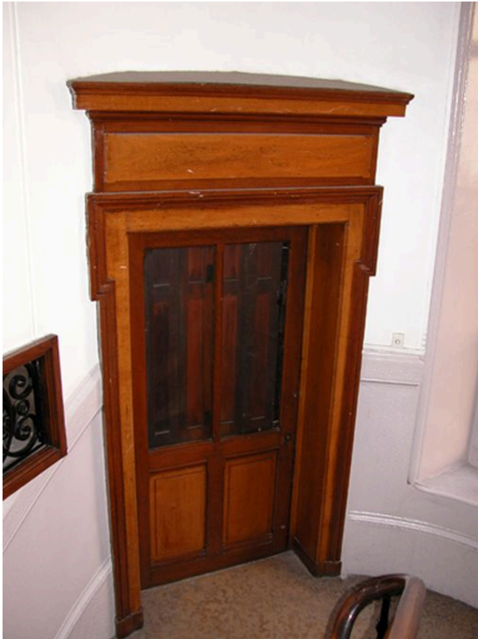
Porte de la loge de concierge donnant sur le premier repos de l'escalier
