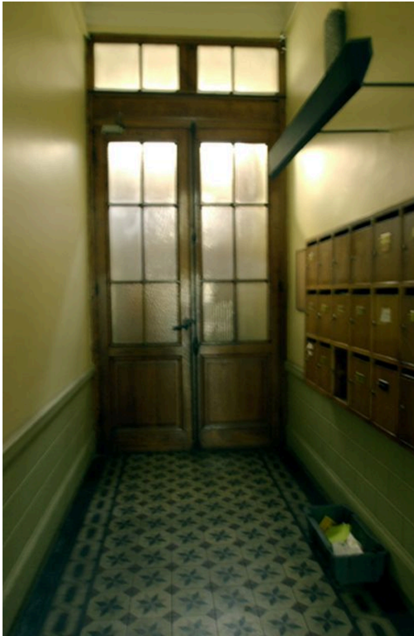
Vue du vestibule vers l'entrée
