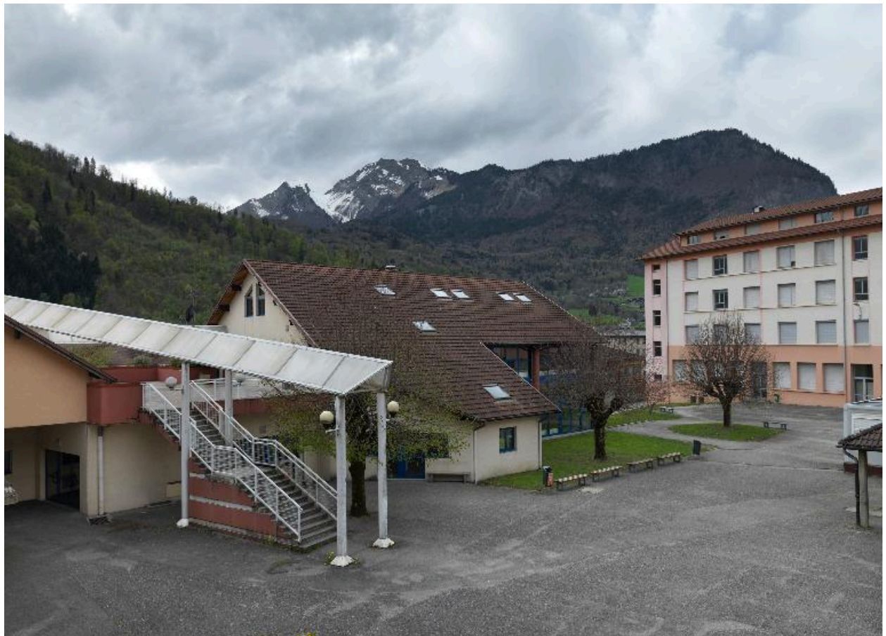
Bâtiment H, vue d'ensemble depuis le nord-est
