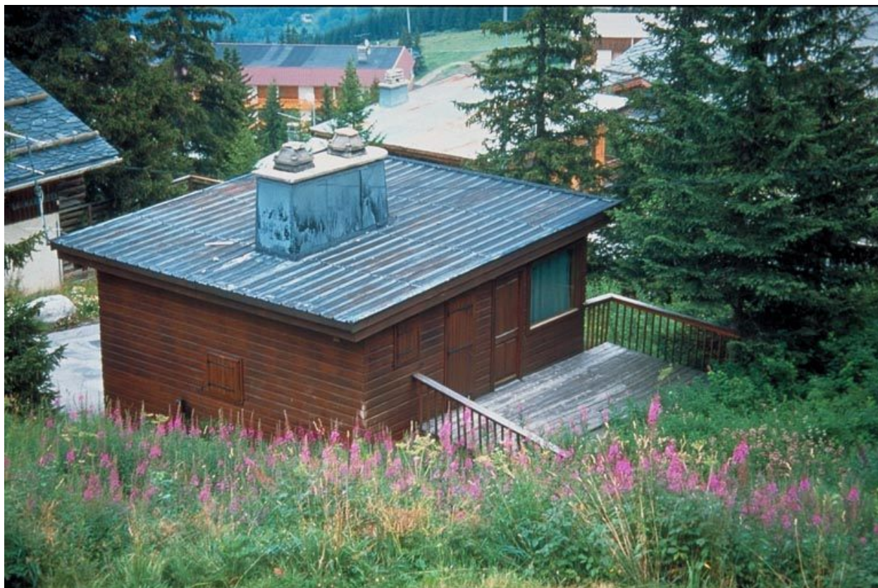
Vue de la toiture
