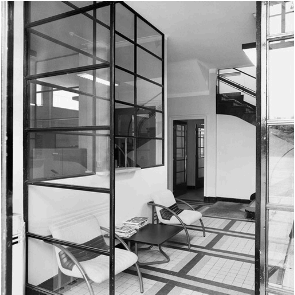
Entrée principale du bâtiment administratif
