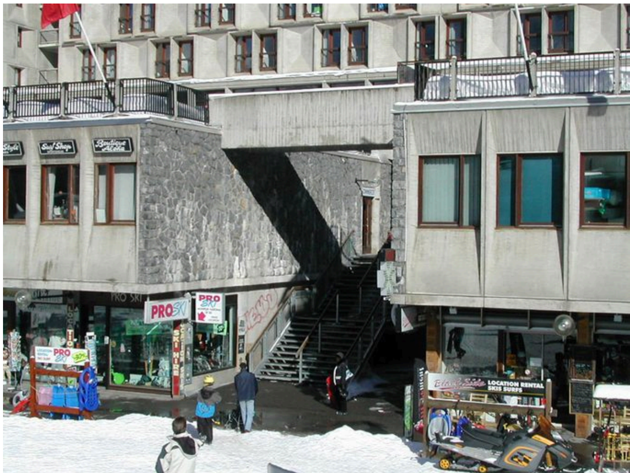
Départ de l'escalier entre les bâtiments G et H
