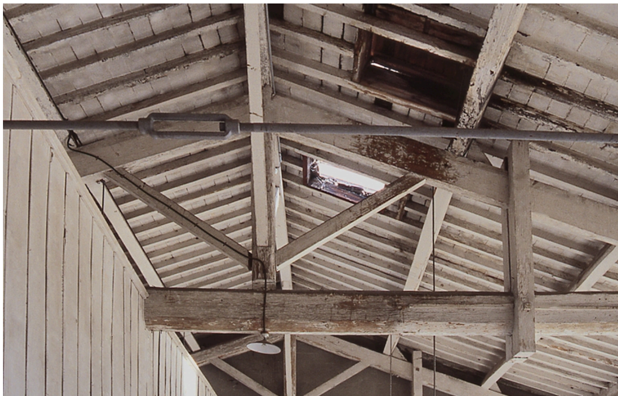
Charpente en bois
