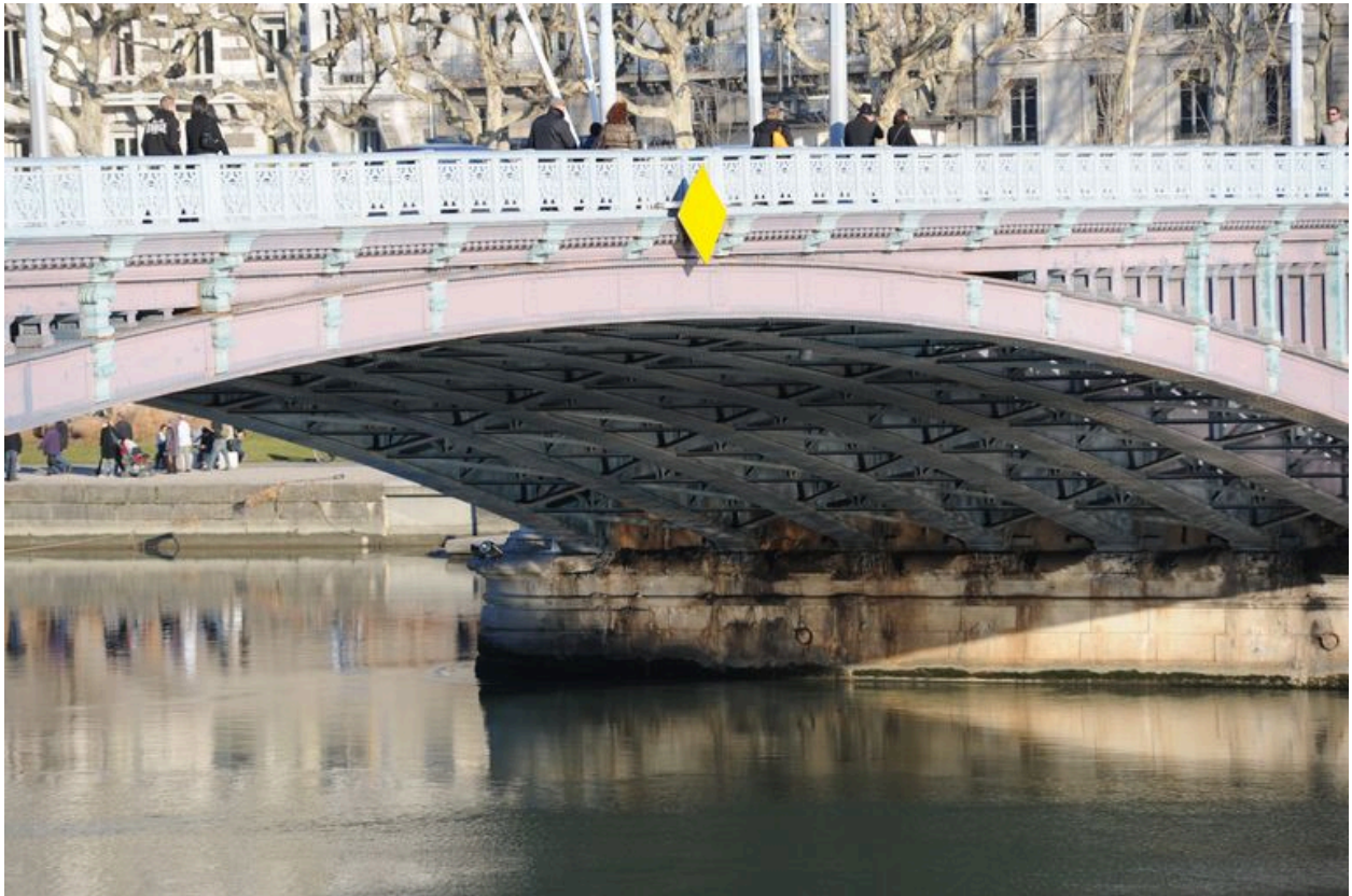
Arche, face aval, de dessous, vue partielle : ancrage à la pile (depuis la rive droite)
