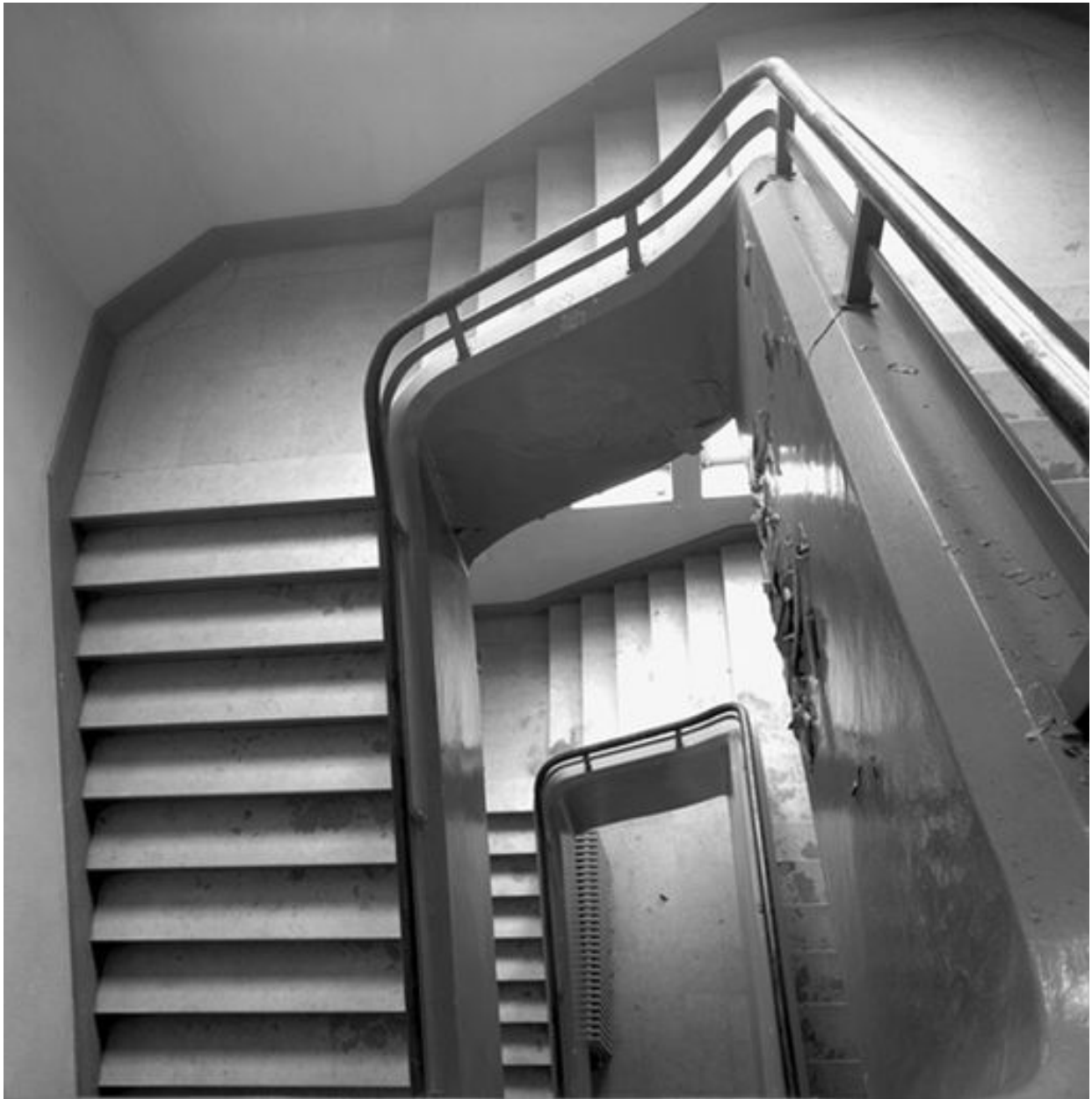
Vue de la cage d'escalier depuis le deuxième étage carré
