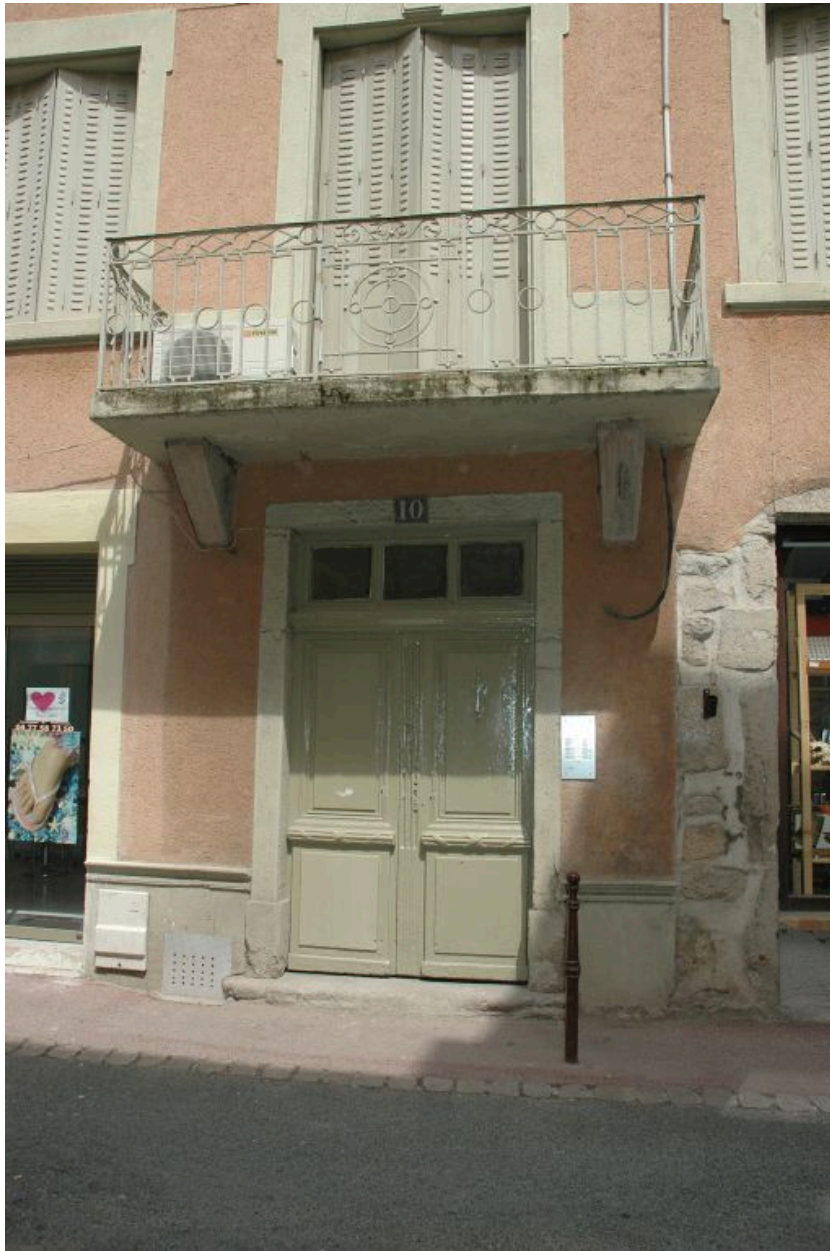
Porte bâtarde à deux vantaux et balcon avec garde-corps en ferronnerie.
