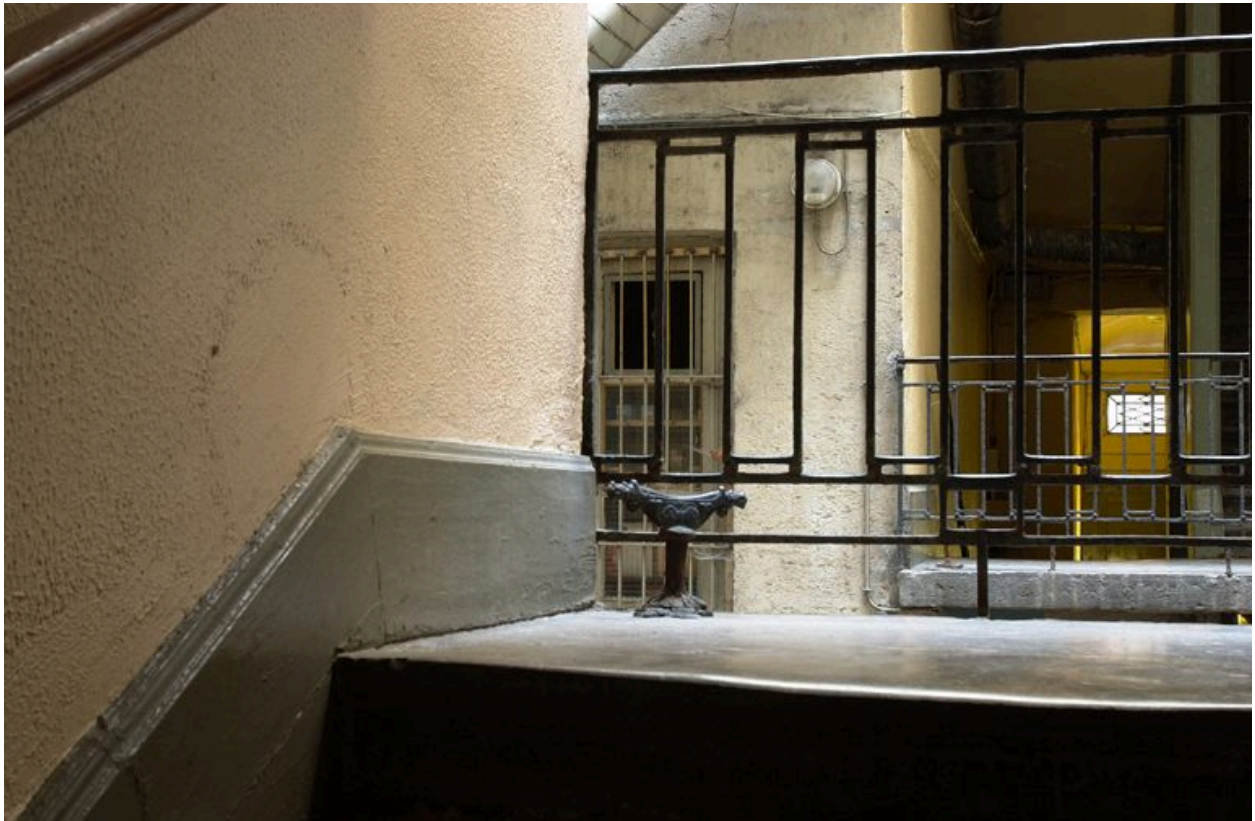
Décrottoir datant du XIXe siècle fixé sur tous les repos des deux escaliers
