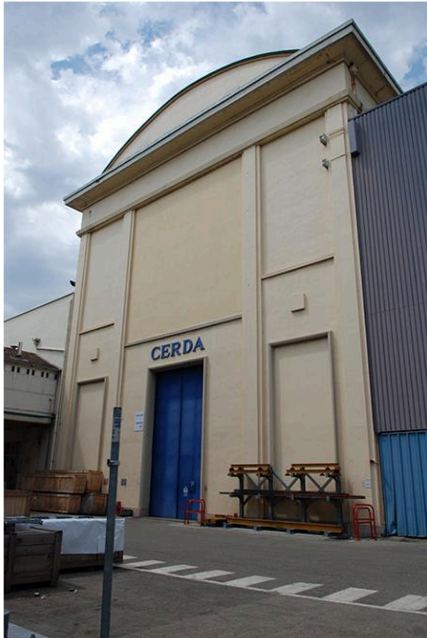
Centre de recherches CERDA
