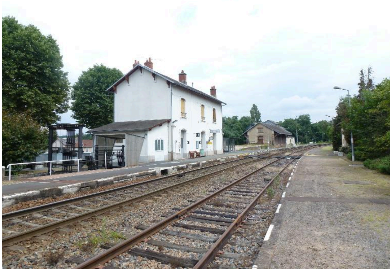
Gare de Vallon-en-Sully. (Photo chercheure).
