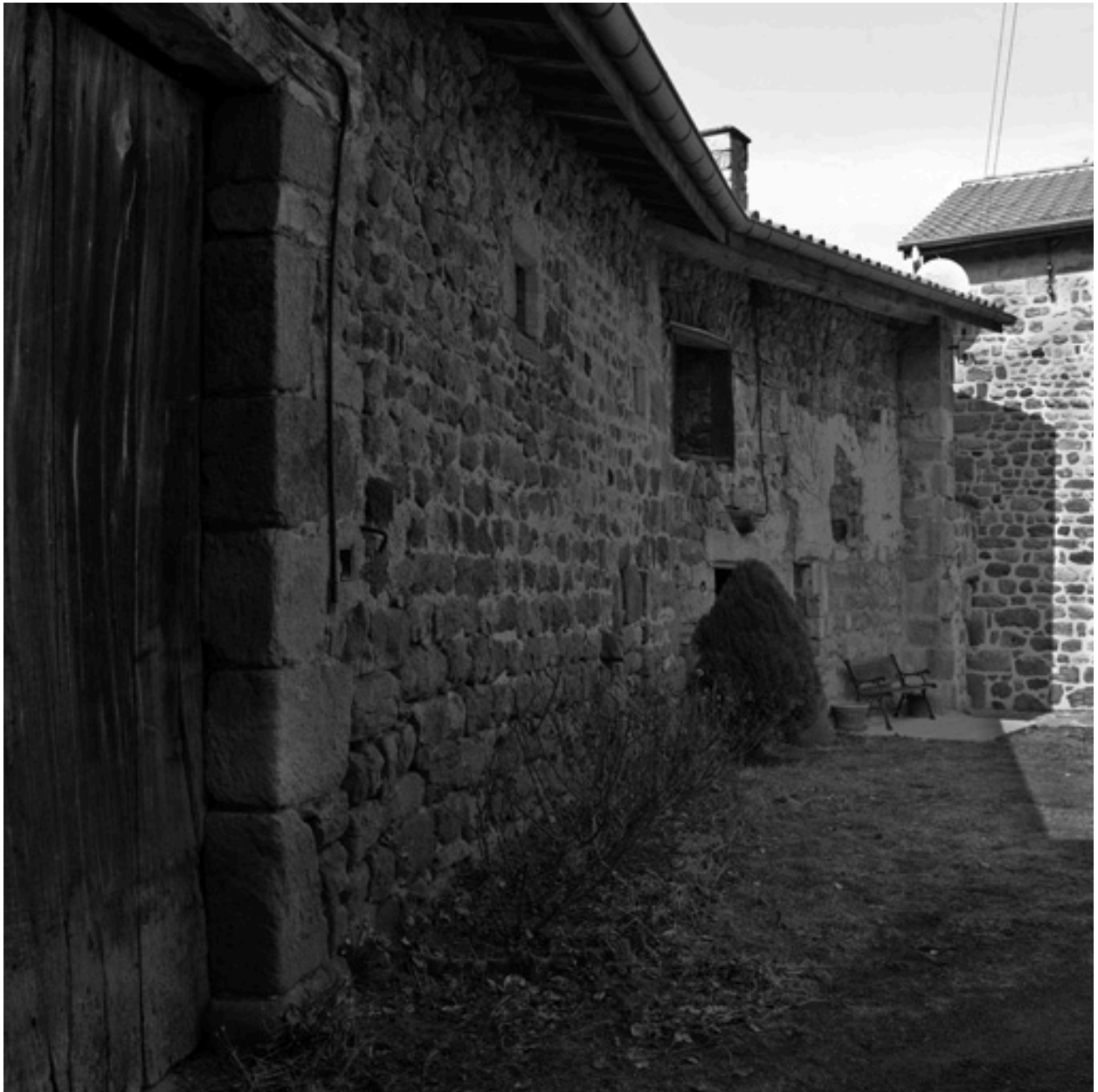
Vue latérale de la façade est du logis ancien et de la grange, depuis le sud-ouest.
