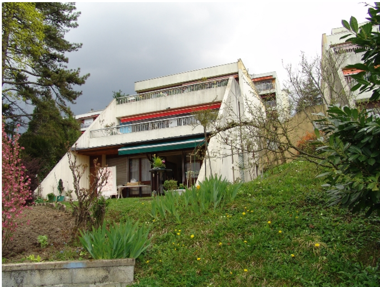
Façade principale de l'immeuble nord
