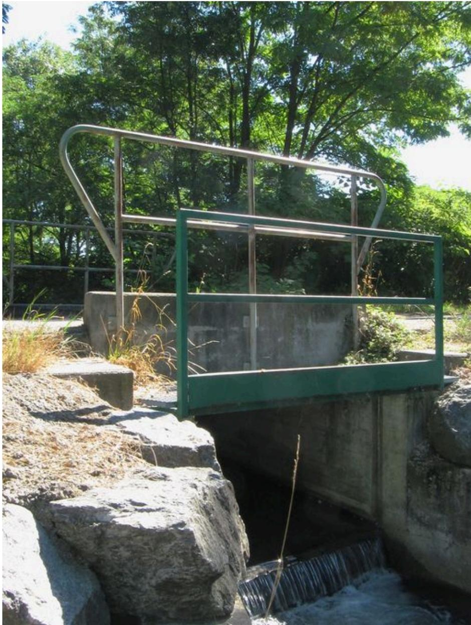
Ponceau-cadre en béton, juste en amont de la rampe d'accès rive droite du pont des lônes
