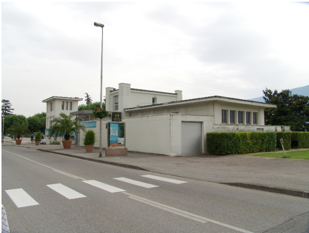
Vue d'ensemble prise du N-E
