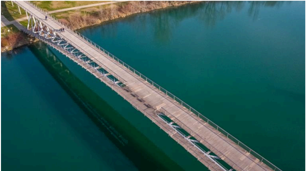
Vue d'ensemble de la passerelle de la Paix détail tablier (drône).
