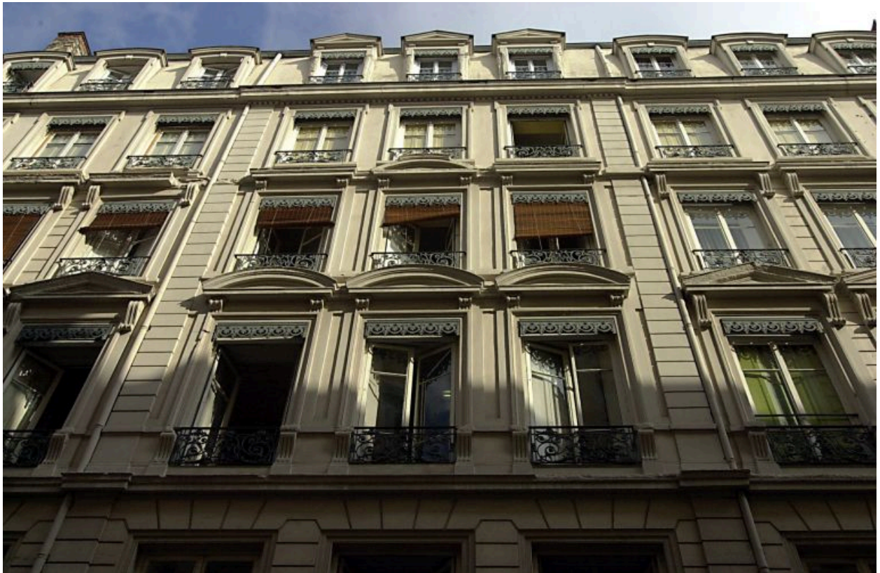
Façade, détail de l'élévation
