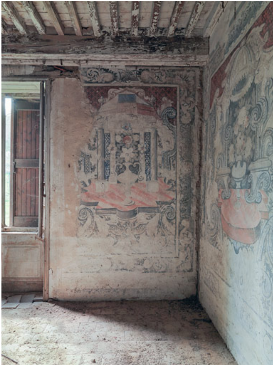
Mur ouest : vue du panneau à droite de la fenêtre.
