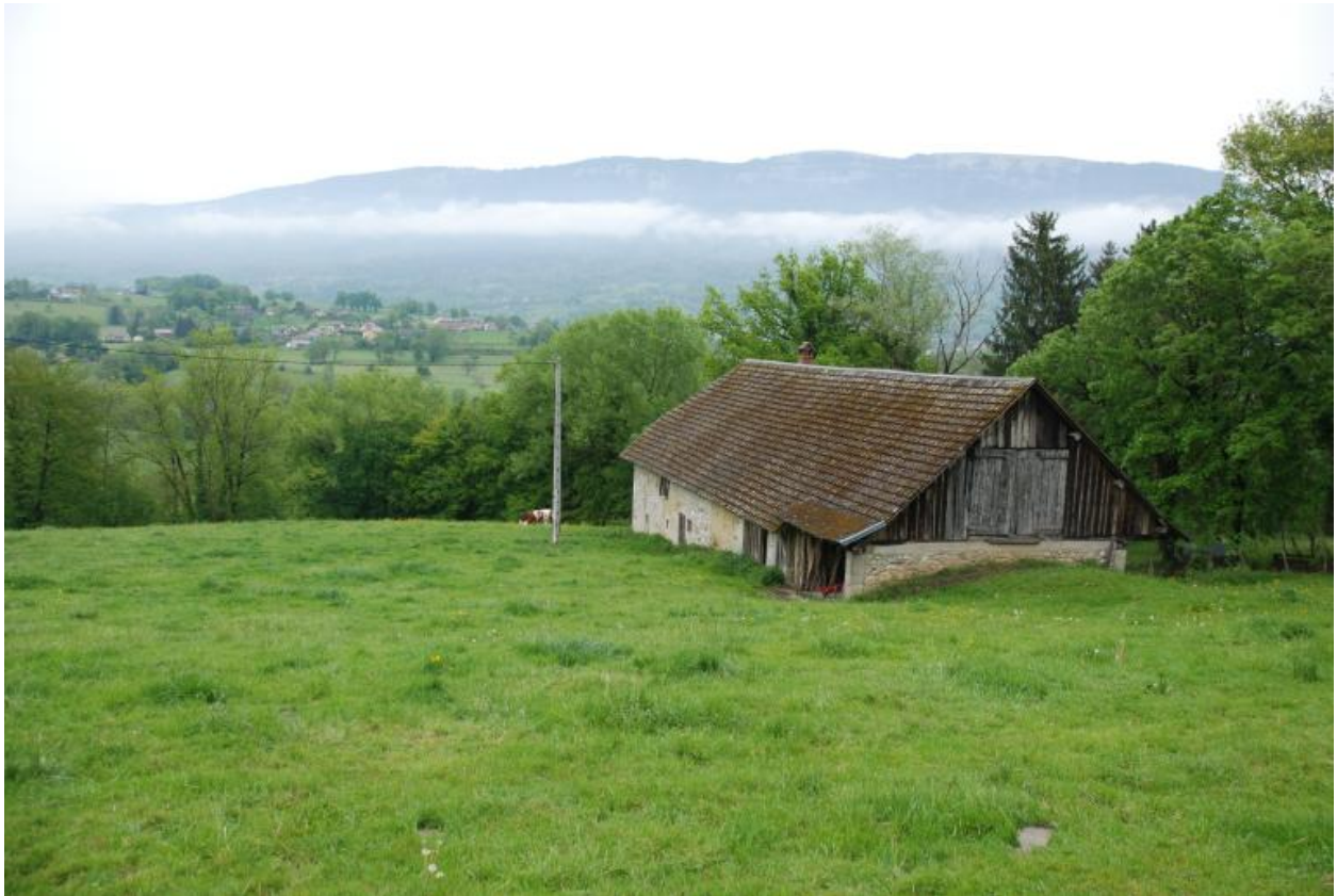
Vue d'ensemble de trois-quarts, depuis le nord-ouest.
