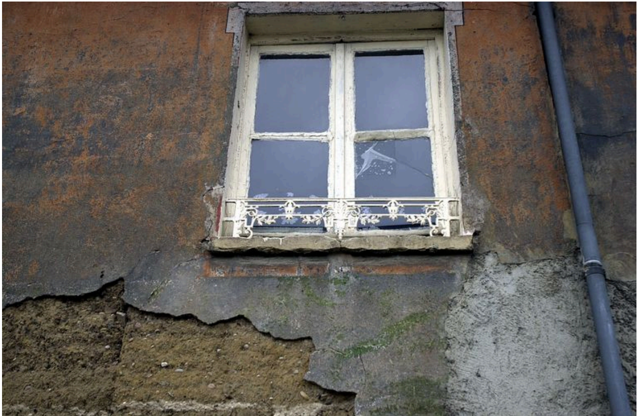
Elévation sur rue : détail d'un garde-corps
