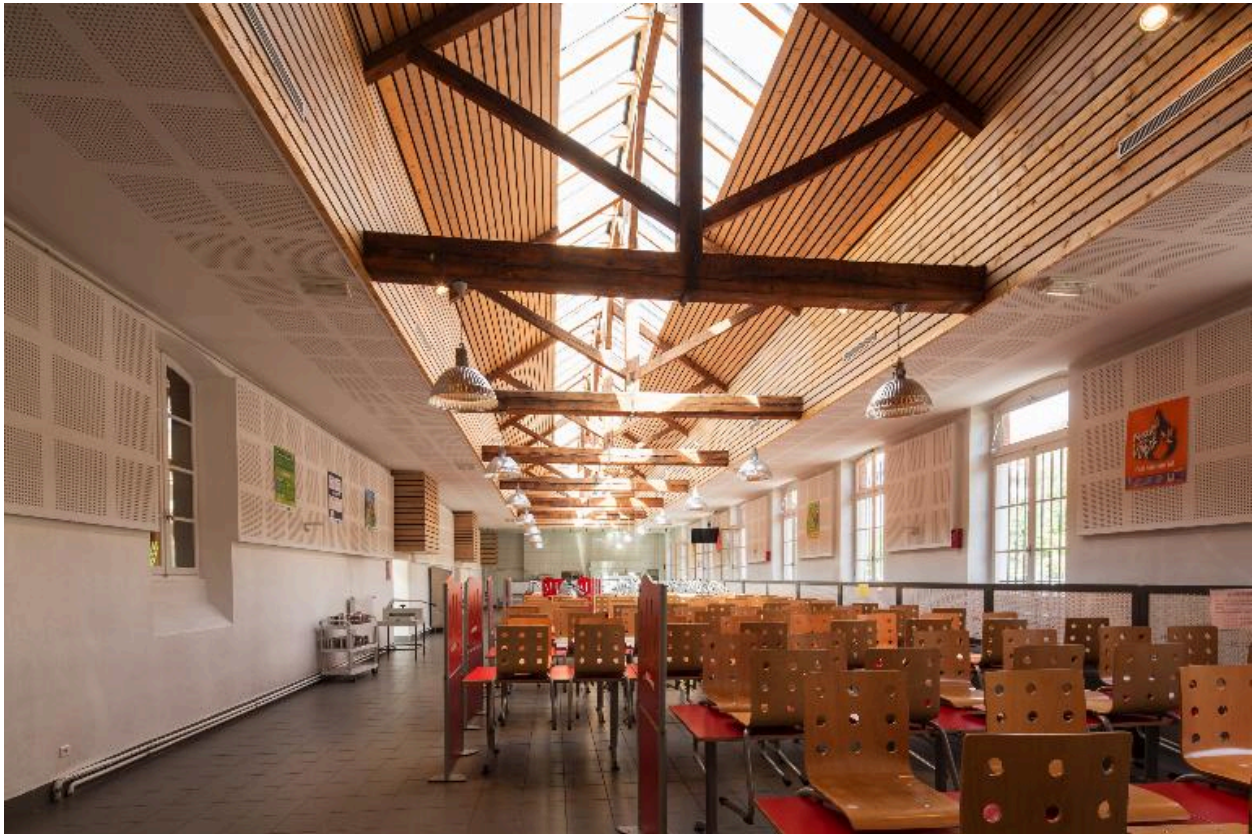
Réfectoire. Salle de restauration éclairée par des sheds.
