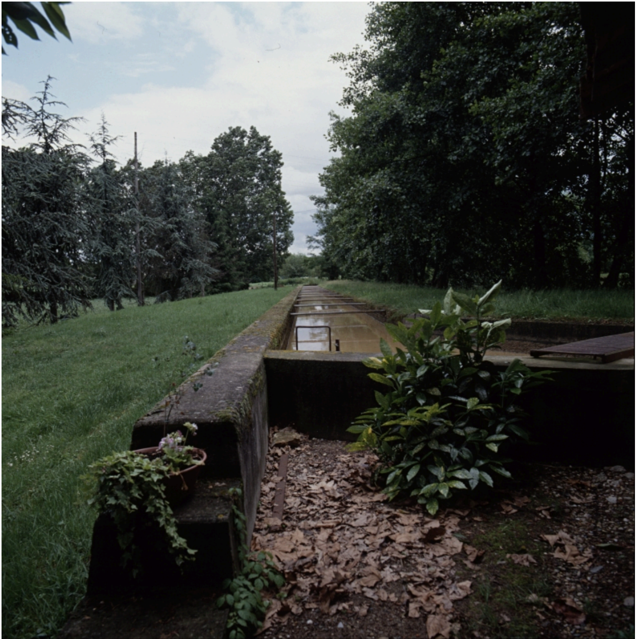
Arrivée du bief, vue prise depuis le nord-ouest.
