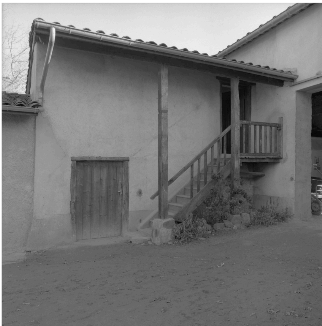
Etable et logement d'ouvrier.
