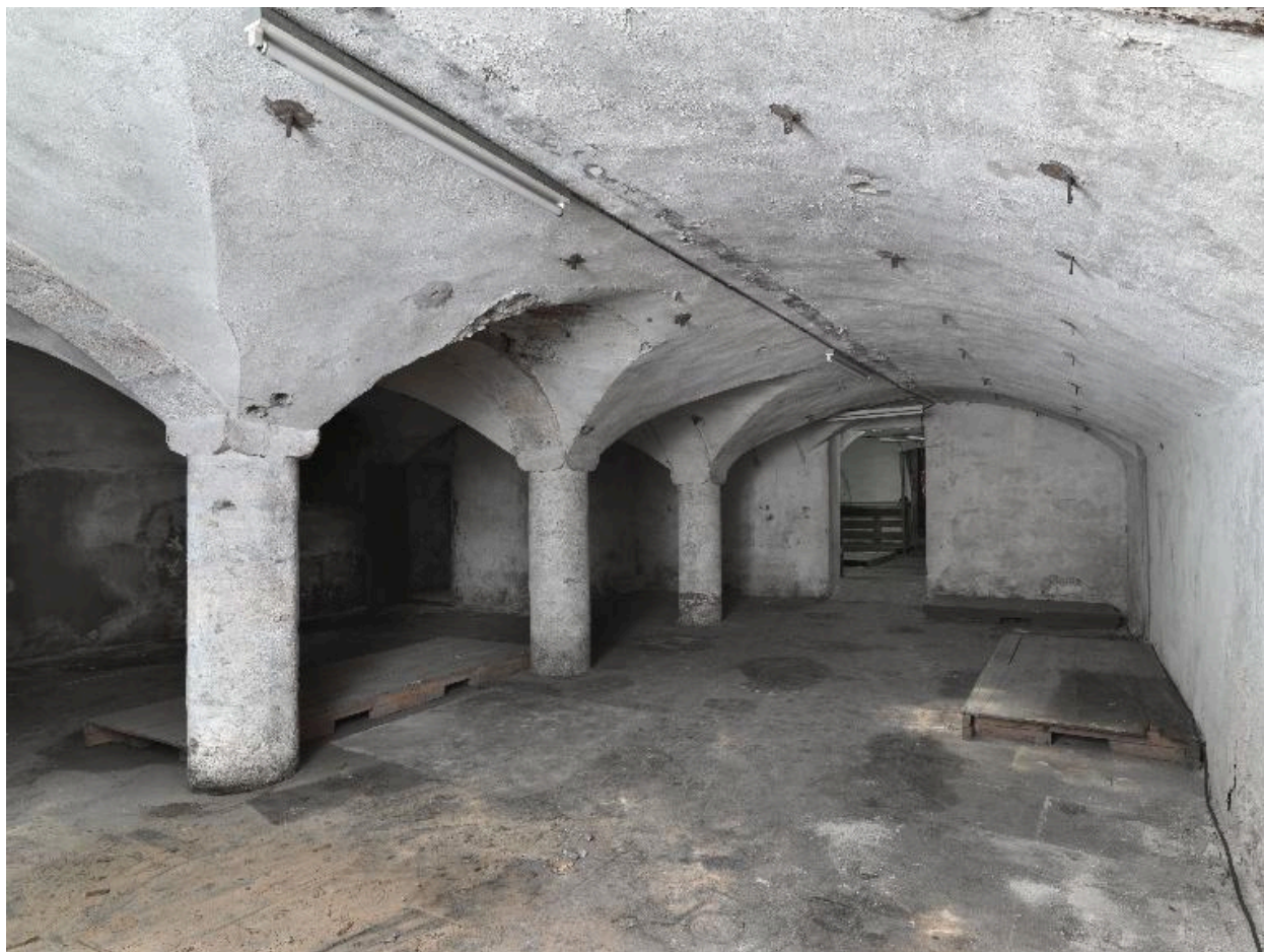
Vue d'ensemble des voûtes des lieux de stockage.
