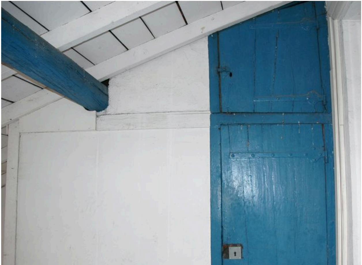
Placard aménagé au sud du dernier palier
