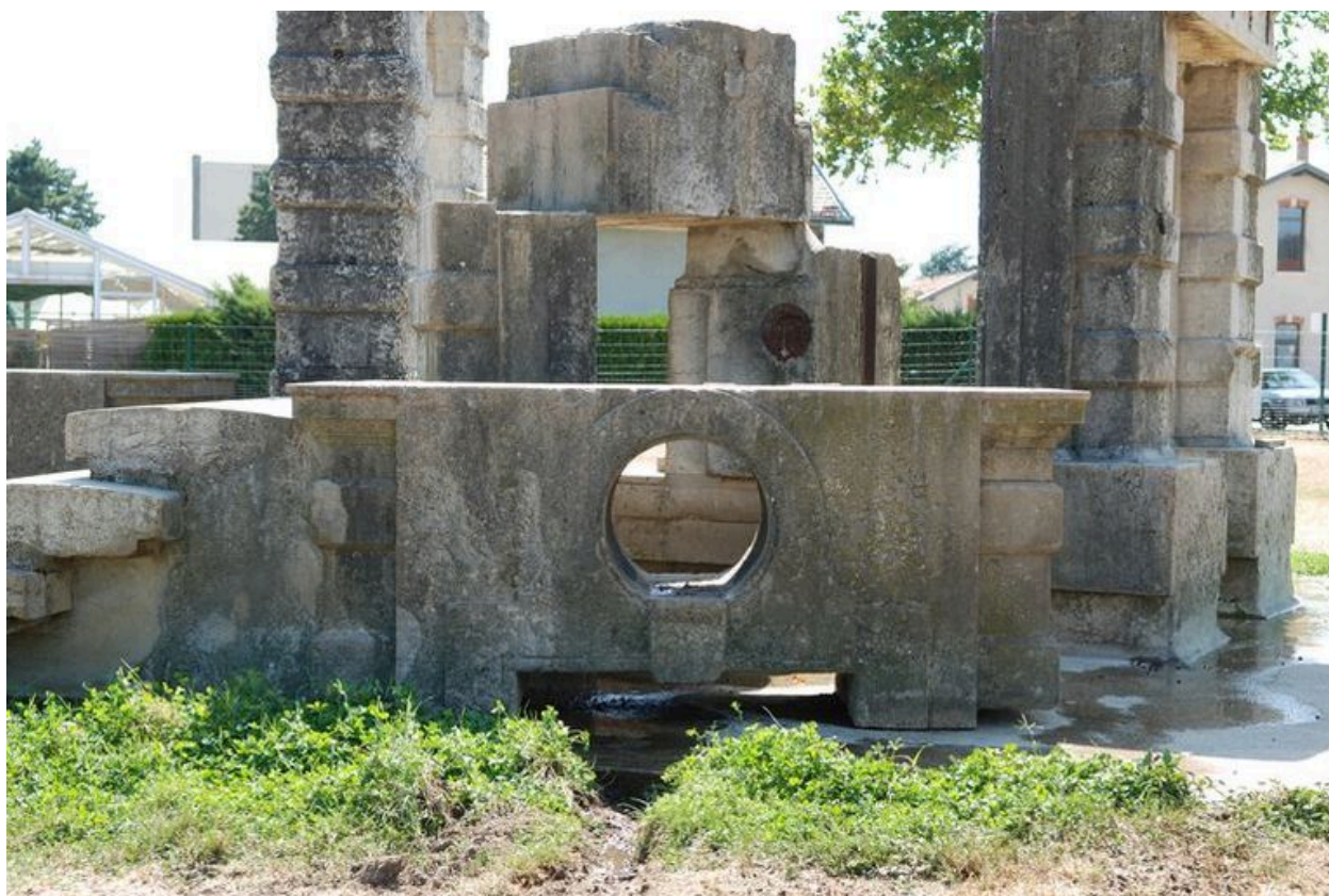
Détail des vestiges des portails des pensionnats depuis le nord, parc aux chèvres
