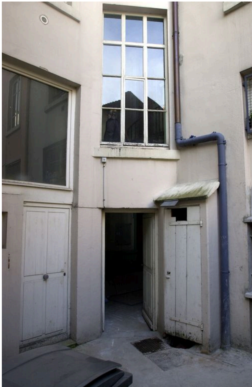
Elévations sur cour, partie inférieure
