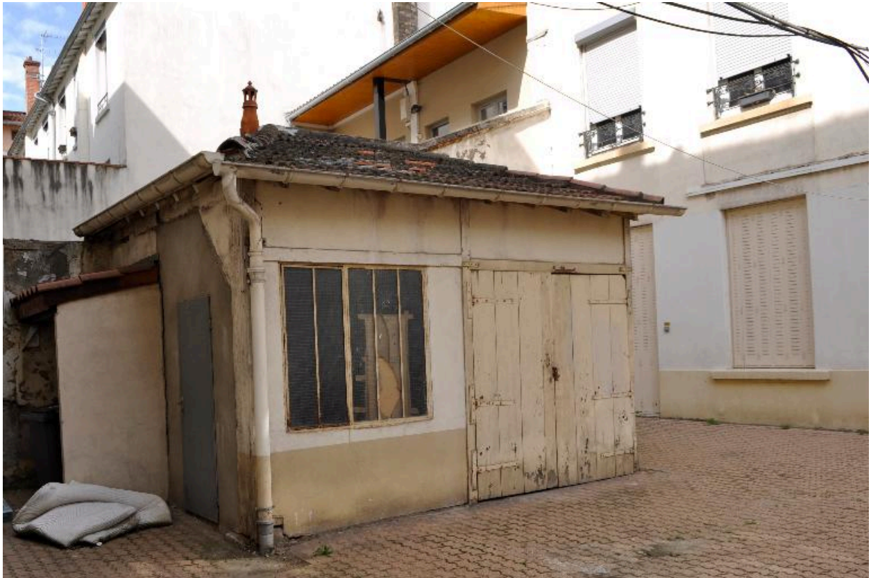
Remise située dans la cour, côté sud
