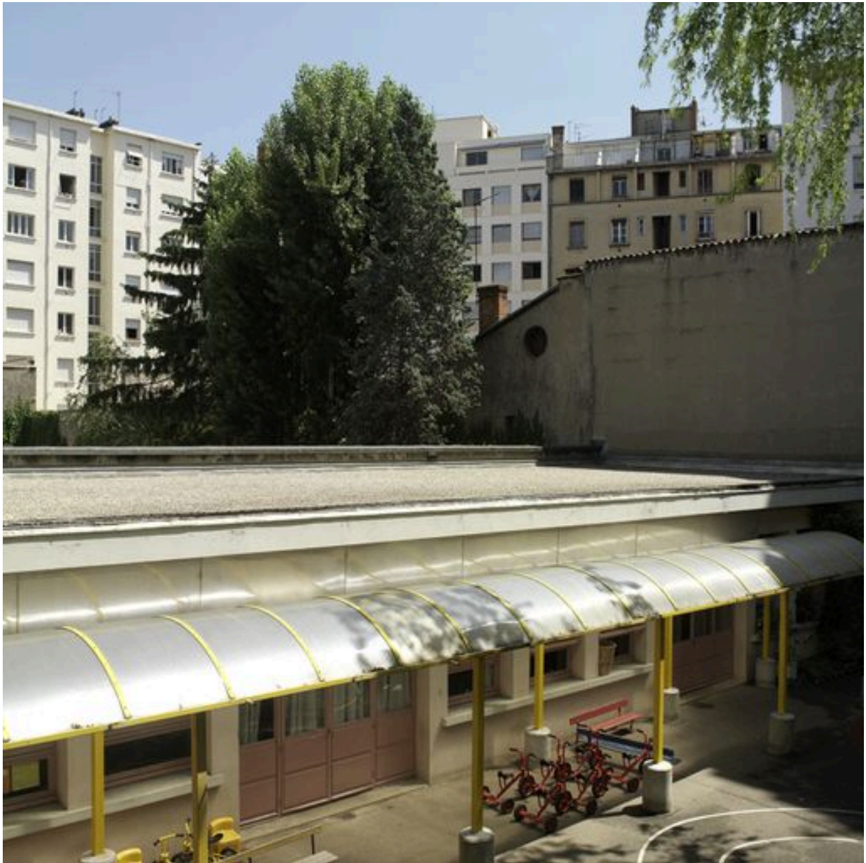
Toit terrasse de l'école maternelle
